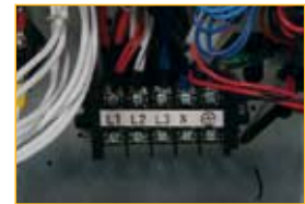
Außengerät KXZ: Mechanikraum
